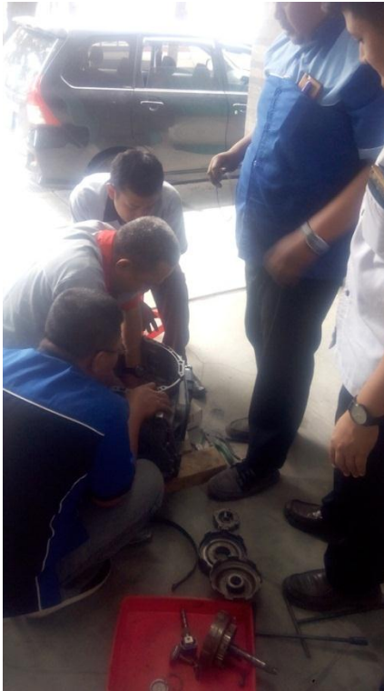
Foto dokumentasi 5. Overhaul transmisi otomatis
